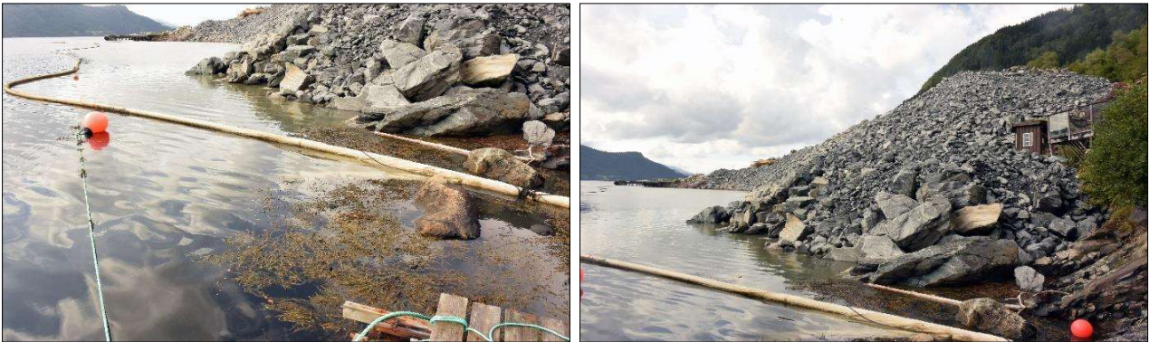
Figur 4-1 Stasjon FG2 i 2023, lokalisert rett ved siden av utfyllingsområde.
